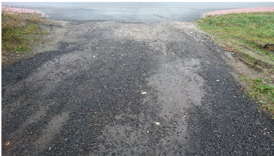
Zjazd drogi wewnętrznej działka 212/13 data wykonanie fotografii 21 października 2016 roku
